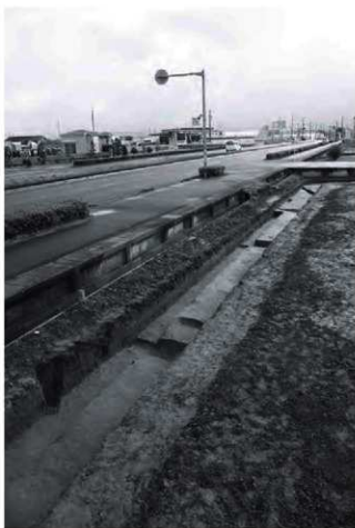
3 I-B区 完掘状況 北西から
