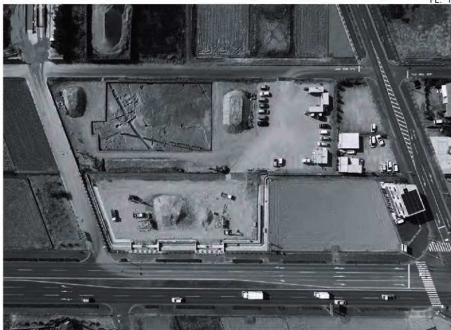
1 調査区全景 直上から
