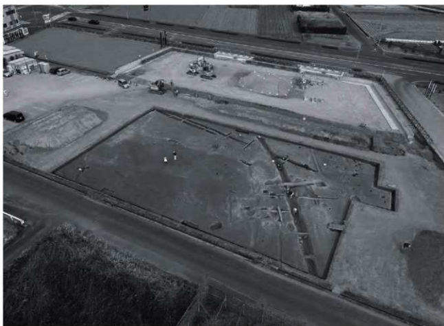
2 V区 掘削状況 南西から
