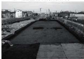
4. 2-4区 南側西部調査完了状況(西南西から)
