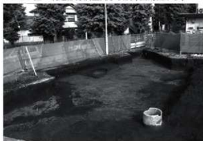
3. 2-5区東側 南側東部調査完了状況(北西から)
