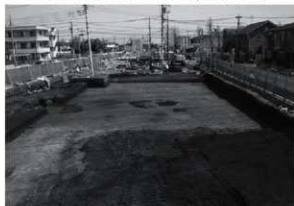
6. 2-4区 南側東部調査完了状況(西南西から)
