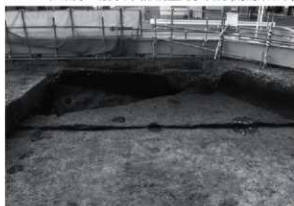
8. 2-5区東側 北側東部調査完了状況(2)(南南東から)
