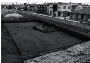
7. 2-4区 北側西部調査完了状況(東から)
