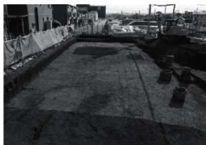
2. 2-5区東側 南側西～中央部調査完了状況(東北東から)
