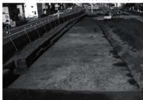
8. 2-4区 北側中央・東部調査完了状況(西南西から)
