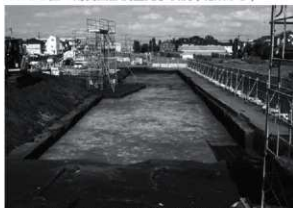
3. 2-2区 南側東部調査完了状況(西南西から)
