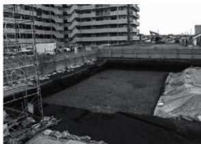
1. 2-2区 南側西部調査完了状況(北東から)
