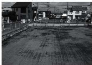
5. 2-1 区 埋め戻し完了状況 (南南東から)
