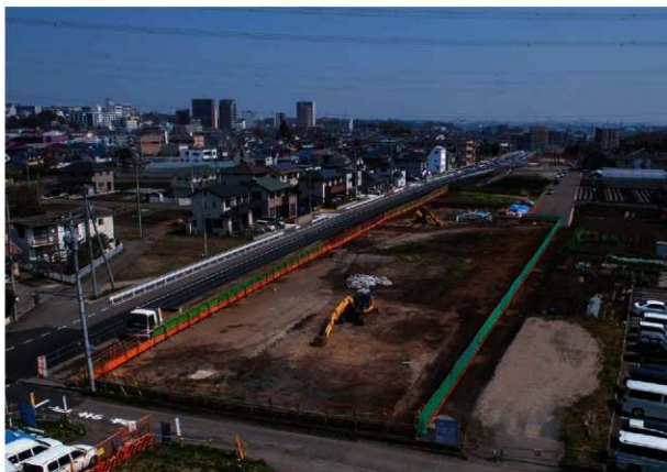
1. 2-2区 調査前状況(南西から)
