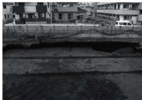
6. 2-5区東側 北側中央部調査完了状況(南南東から)
