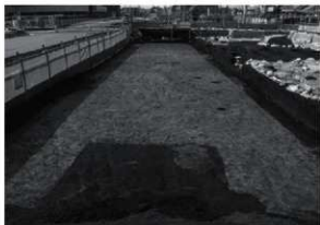
6. 2-2区 北側南西部調査完了状況(西南西から)
