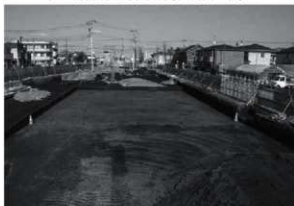
5. 2-4区 南側中央部調査完了状況(西南西から)
