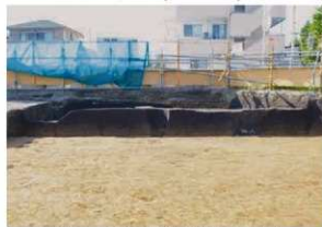
5. 土層断面 2-5 区東西ベルト (南南東から)
