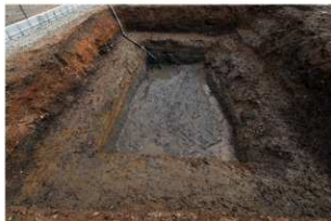
⑥ 3 次西堆積状況
