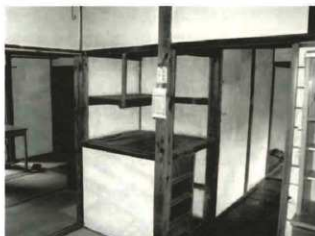
写真 4-25 台所棚を4.5畳から見る
