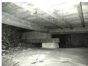
写真 4-15 643A 基礎と土台
