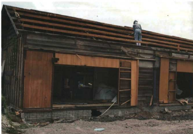
解体工事 (64A 南面)
