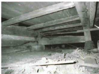
廊下部分床下
