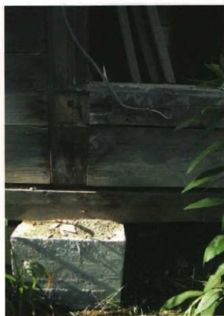
基礎・土台・柱 (64C)
