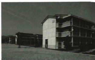
写真 2-7 改良住宅（南面）
