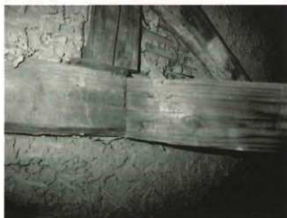
写真 6-51 664 釘打ち火打梁
