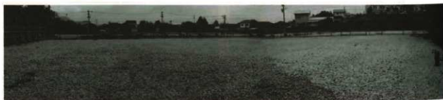
1 期解体工事後
