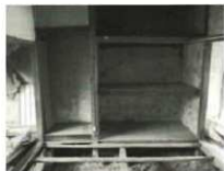
写真 4-2 床ノ間まわり
