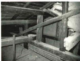
写真6-48 664 床ノ間・押入部分
