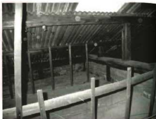
写真 6-1 製材された材による母屋 (64A)
