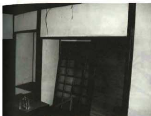
写真 4-24 床ノ間まわり
