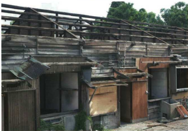
解体工事 (64C 北面)
