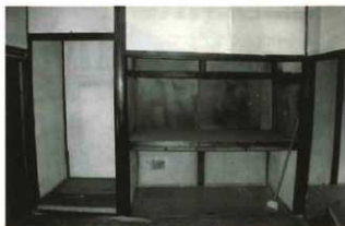
写真 4-7 床ノ間まわり
