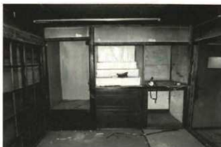
写真 4-17 床ノ間まわり
