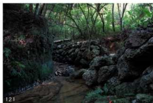
写真 5.20 ヒージャーガーの護岸状石積【11 地点】
