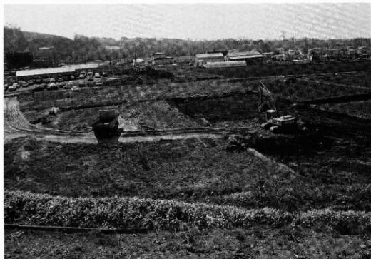
1 表土除去風景（北から）
