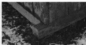
福岡市宇宮歌 村社八幡神社 拝殿土台
