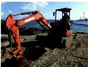
5 確認トレンチ掘削状況（T.P. 2-01）
