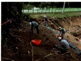
3 清掃作業状況
