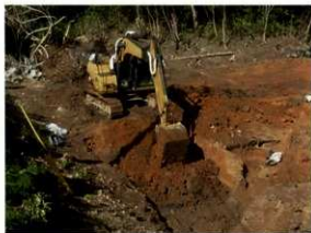
2 試掘トレンチ掘削状況 (T.P. 1-01)
