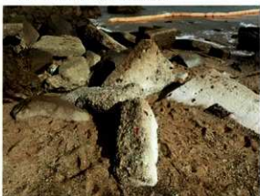
8 橋梁材ナンバリング状況
