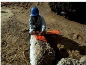
7 橋梁材ナンバリング作業状況
