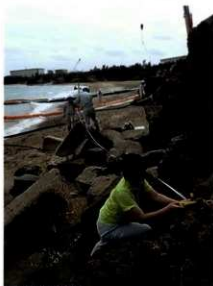
1 測量作業状況
