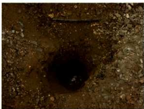
6 T.P. 2-01 における埋設物確認状況
