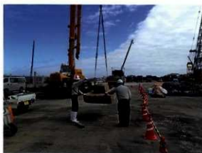
4 橋梁材の積み降ろし状況
