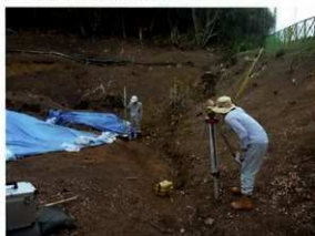
7 測量作業状況
