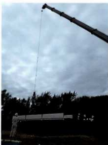
3 橋梁材の積込み状況
