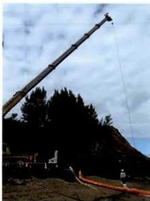
2 橋梁材の移動状況
