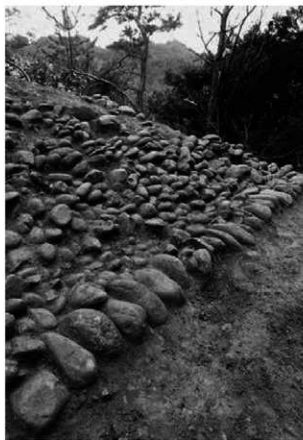
2 北側下段葺石詳細（東から）
