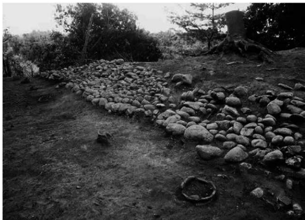
1 東側上段葺石検出状況（北東から）
