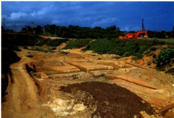
卷頭図版 2 調査区遠景
