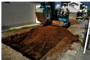
1. 表土掘削作業
