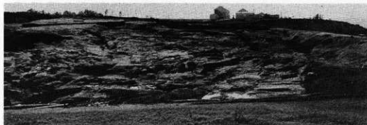
2 中の沢の東側の土砂崩れ跡
