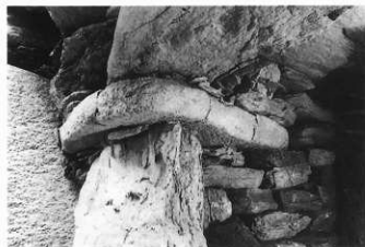
7. 右袖石上部状況 (玄室より)
