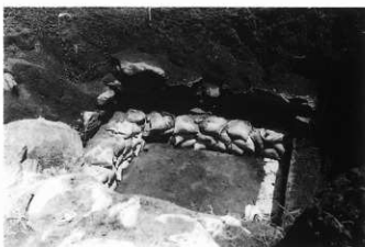
5. 石室埋め戻し状況 (四壁に土嚢を積み壁面を保護)
