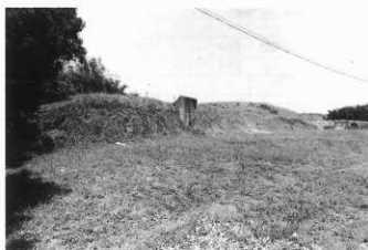
3. 調査前状況（南西より）
