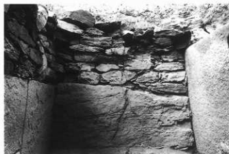
1. 玄室奥壁状況
