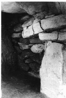
2. 灰道部（前室）左側壁 石積状況
