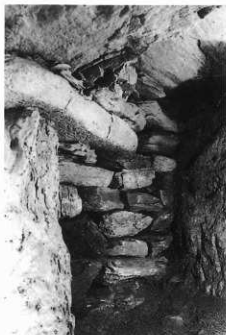
1. 灰道部（前室）右側壁 石積状況
