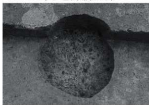
4. SK152 全景 (北北西から)
