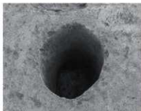
6. SP448 全景(北西から)
