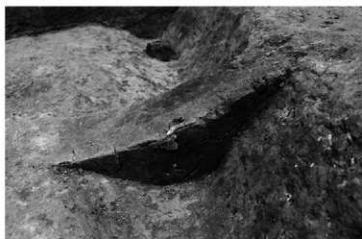
SD-05断面(南西から)
