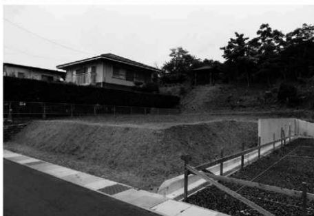
調査前状況(南西から)
