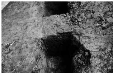
SD-02断面(南西から)
