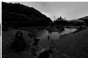
修理後（北東部取水口側から）
