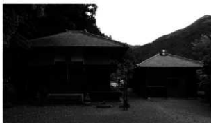
修繕前 (左 観音堂、右 幕屋)
