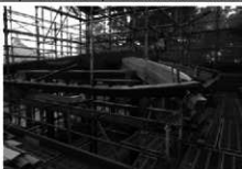
実相寺庚申堂保存修理工事の様子
