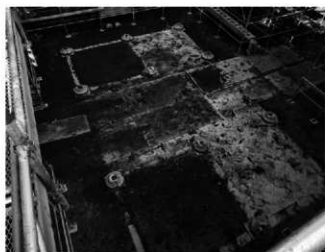
解体状況 2階足場南西より
