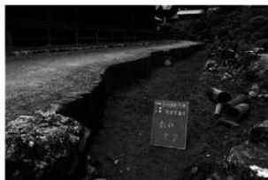
乱杭（丸太杭）設置完了
