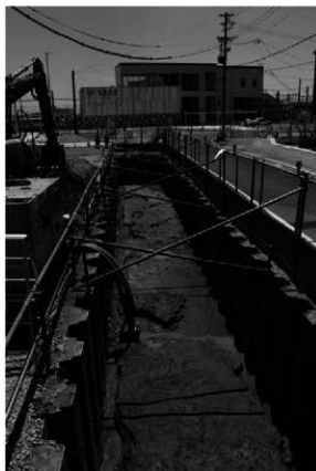
調査区完掘状況（北から）
