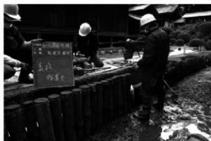
乱杭（丸太杭）の設置作業
