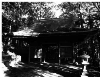
施工前 全景 西面
