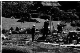
蓬莱出島の石組の修理作業
