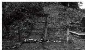
完了後 近景 (北から)
