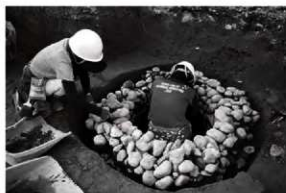
浜松城下町遺跡 13 次 作業状況
