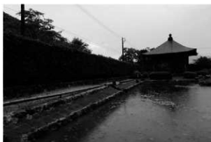
修理後 南側護岸（北東側から）
