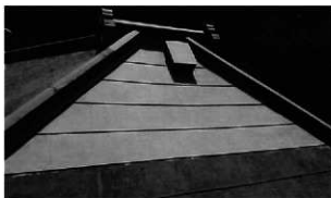
修理の様子 (下地の錆落としと下塗り)
