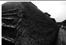
宝林寺方丈保存修理工事の様子
