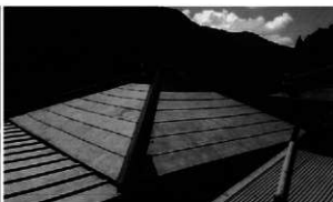
修理の様子 (下塗りの上に中塗り)
