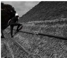
施工中 差し茅 正面
