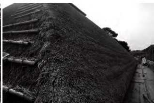
施工中 差し茅 北東面
