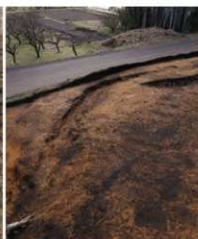
2号溝 完掘 (北東から)
