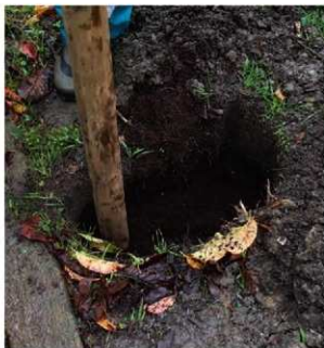
写真3 桜施肥箇所掘削状況
