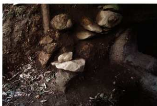
写真 16 Y133 羨道左側壁（西から）
