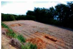
2. 試掘坑設置状況
