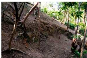
1. 斜面切土状況
