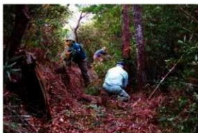
1. 伐採作業風景
