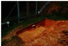
2. T.P.15 掘削状況
