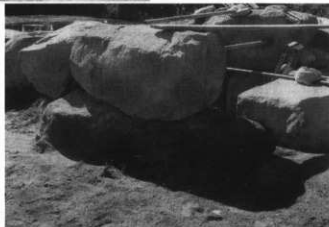
左側壁の裏込め部（北から）
