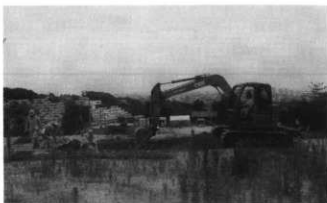
調査区機械掘削の状況（北西から）
