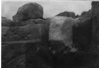
奥壁裏込めの状況（東から）
