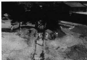
第37図 調査風景(北から)
