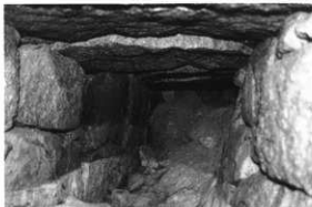
第3図 検出時の排水用暗渠内部
