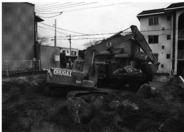
調査地全景 (北西から)
