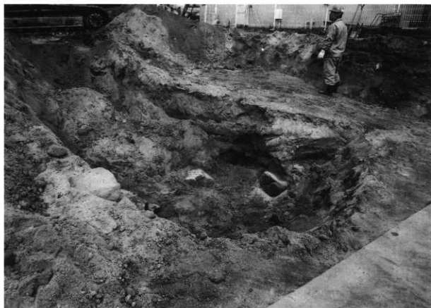
工事掘削立会状況 (南西から)
