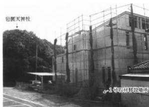
第87図 移設場所の遠景（西から）
