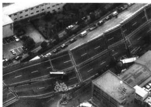
第22図 阪神・淡路大震災による阪神高速道路倒壊状況 (平成7年1月17日撮影・アジア航測株式会社提供)
