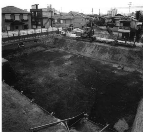
第4遺構面（西）全景写真（北東から）
