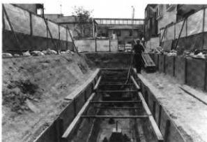
第283図 3段目調査風景（北から）
