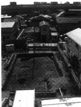
第7図 若宮町住宅1号棟建設現場から第4地点と若宮町を臨む (北から)
