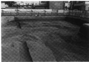
第70図 遺構完掘状況全景（西から）
