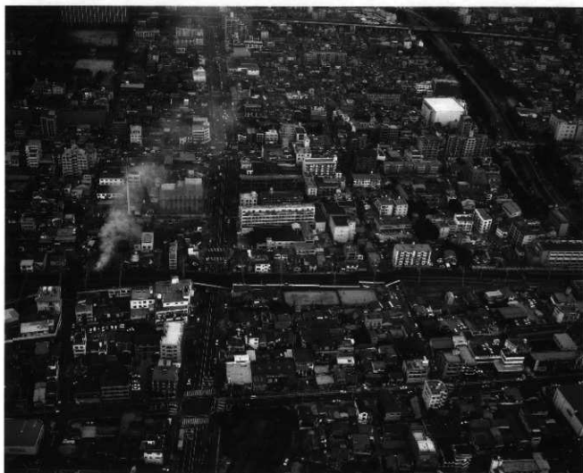
阪神電鉄橋梁落下の地震被災〔アジア航測株式会社提供〕
