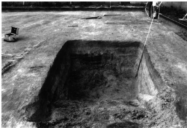
テストトレンチ掘削状況（南から）
