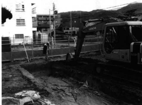
発掘区重機掘削状況 （南西から）
