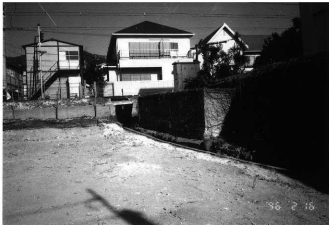
調査地の現状（南西から）
