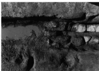
II区暗渠下部配石状態（東から）
