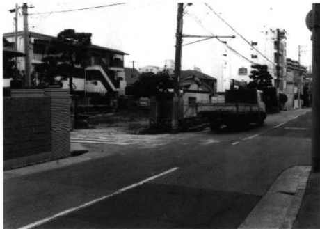
調査地近景 （北東から）
