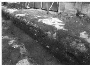
②6区(南西から)
