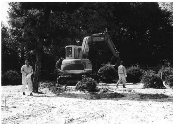
発掘調査表土除去作業開始（北東から）
