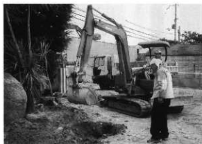
②調査風景（北西から）
