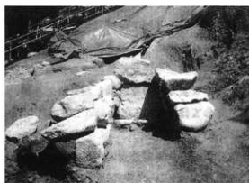
横穴式石室解体状況
