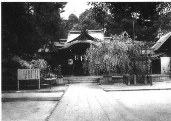
芦屋神社拝殿（南から）
