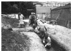
①調査風景 (南から)
