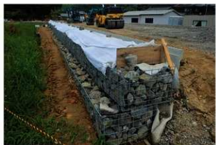
法面龍枠（南西から）
