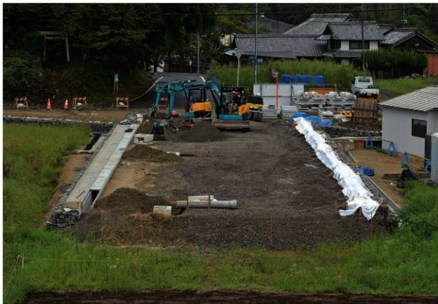
道路工事風景（2区、東から）
