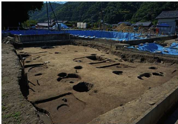
SB 49・50 (南東から)
