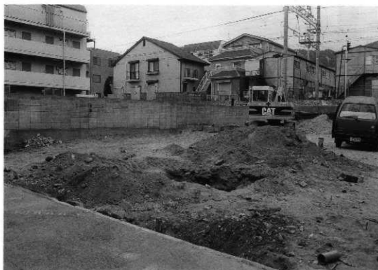
調査地および第2トレンチ掘削状況(南東から)
