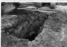
第2トレンチ掘削状況（南東から）
