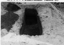
第2トレンチ完掘状態(北から)
