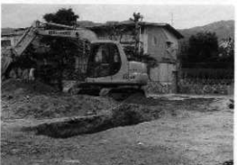
南地区第7トレンチ重機掘削状況(南東から)
