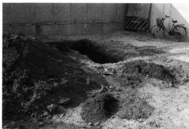
トレンチ掘削状況 （南西から）
