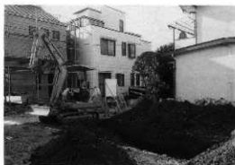
重機掘削状況(北東から)
