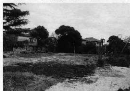
各トレンチ埋め戻し状況(北西から)
