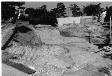
震災により住宅が全壊した 調査地近景（南東から）
