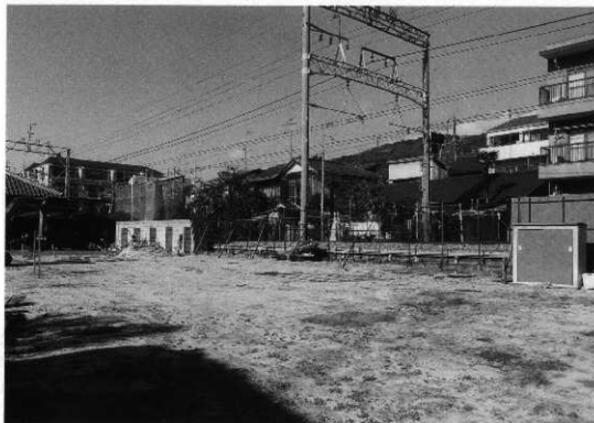
震災により住宅が全壊した調査地近景(南東から)
