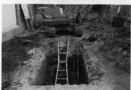
試掘坑掘削状況(北から)
