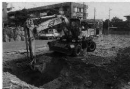
第4トレンチ重機掘削状況 (北西から)
