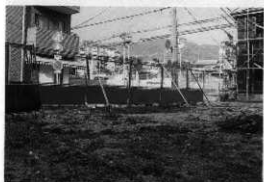
震災により住宅が全壊した調査地の現状(南東から)
