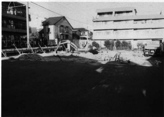
調査地近景(南西から)
