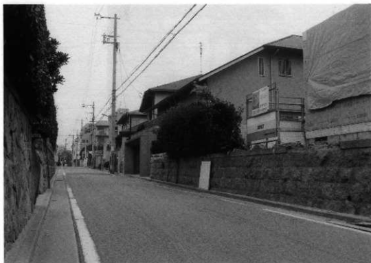
震災により住宅が全壊した調査地近景(北西から)
