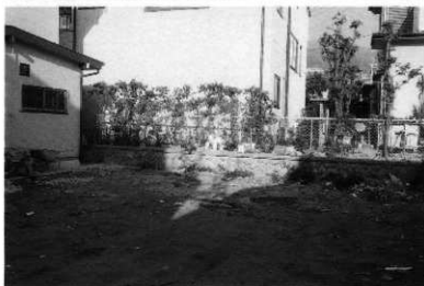
震災により住宅が全壊した 調査地の現状(南から)
