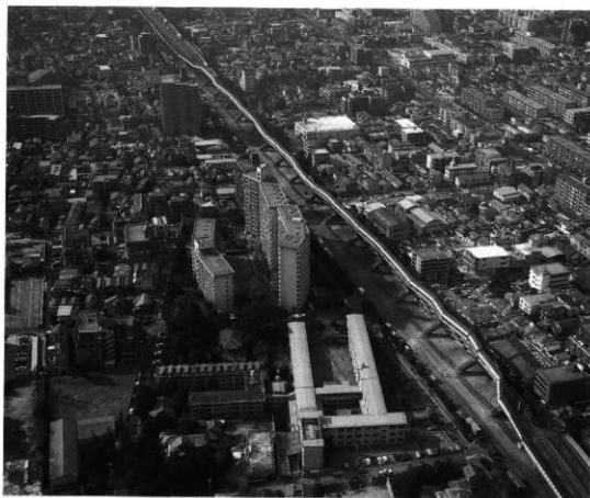
阪神・淡路大震災による阪神高速道路倒壊状況（平成7年1月17日撮影・アジア航測株式会社提供）
