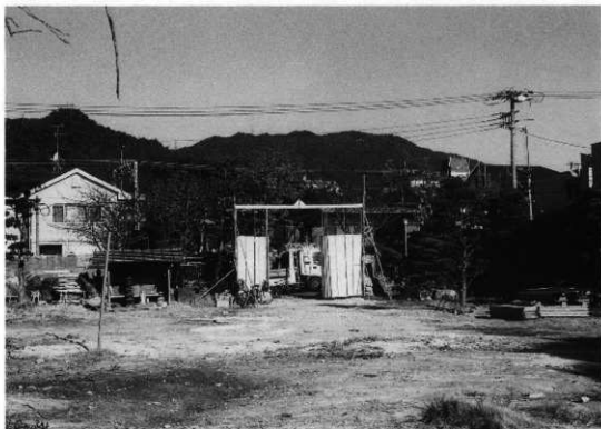
震災により住宅が全壊した調査地の現状(南から)
