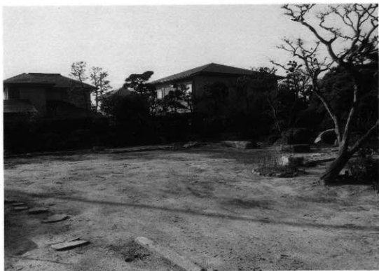
震災により住宅が全壊した調査地の現状〔南地区〕(北東から)
