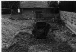
第3トレンチ掘削状況 (北から)
