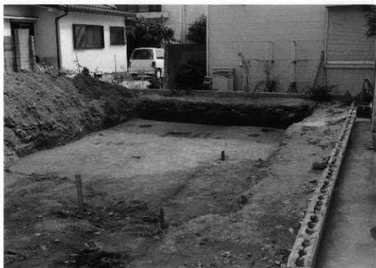
本調査A区遺構確認状況（北西から）
