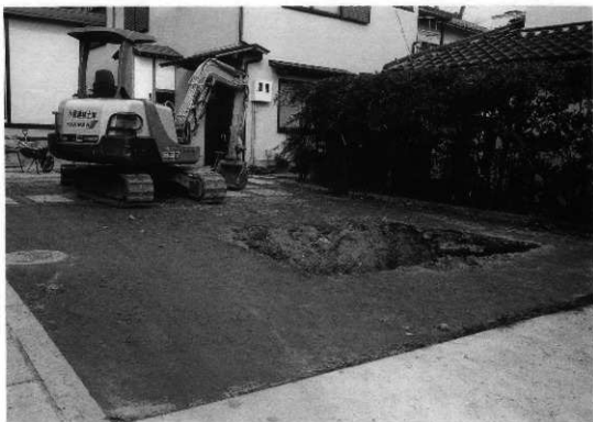
震災により寺院本堂が全壊した調査地近景 第1トレンチ掘削状況（南西から）
