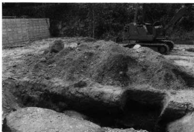
第1トレンチ完掘状況 （南東から）
