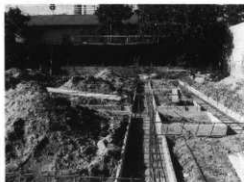
第81図 工事進行状況
