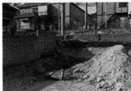
第1トレンチ掘削状況(南東から)
