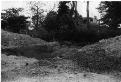
トレンチ設定・掘削状況
