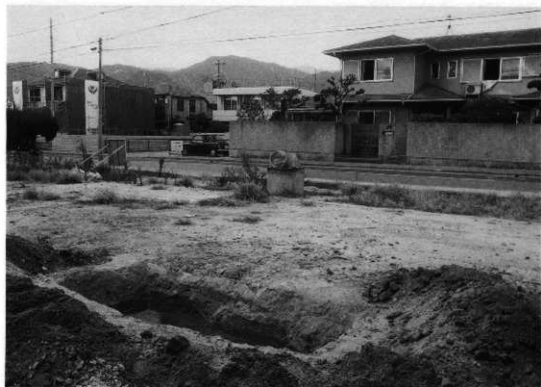
第1トレンチ掘削状況(南東から)
