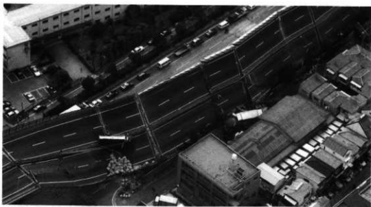
阪神・淡路大震災による阪神高速道路倒壊状況（平成7年1月17日撮影・アジア航測株式会社提供）
