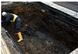
調査坑 R 3 - No.1 (南から)
