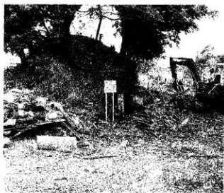
(3) 伊方古墳指定地内の家屋解体状況
