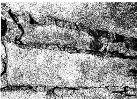
(2) 玄室左側壁の目地 (入口から)
