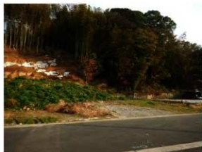
写真 13 計画地南側斜面（駐車場から）
