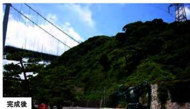
写真20 A案（連続繊維補強土工法）の施工例
