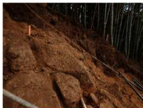
写真 19 遺構斜面の状況（斜面中央部から）
