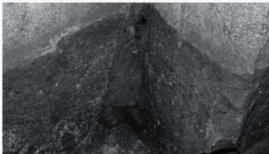
2. 玄室隅部の 状況 (右側壁と袖石)
