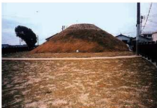
8. 平成 16 年度工事裏側竣工
