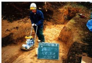
3. トレンチ埋め戻し状況 1 層目 (真砂土)
