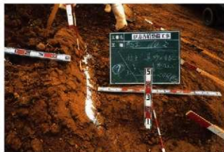
6. 填丘盛土充填状況
