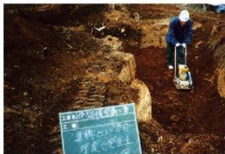
4. トレンチ埋め戻し状況 2 層目 (現地発生土)
