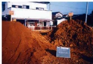
5. 填丘盛土混合土配合状況
