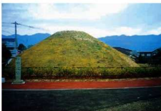
6. 平成 16 年度工事正面竣工
