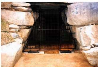
6. 石室入り口部扉設置完了
