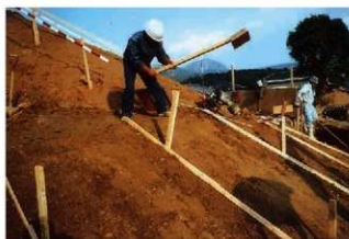
3. 墳丘法面整形状況
