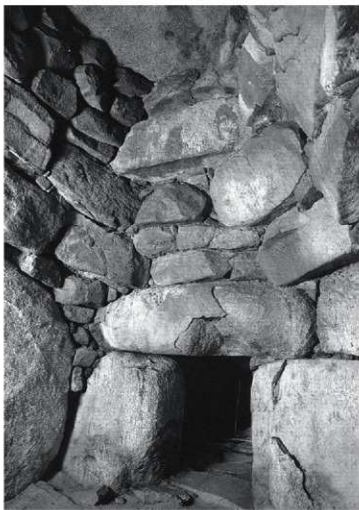
鞍手町新延大塚古墳前壁
