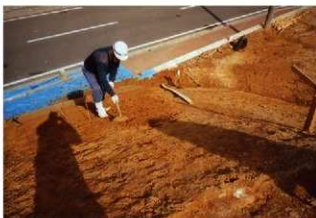
2. 墳丘法面整形状況
