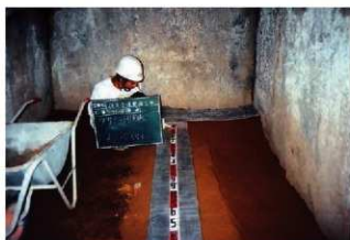
3. 石室内面上排水材敷設状況
