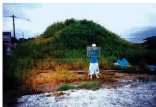
5. 平成 16 年度工事正面着工前
