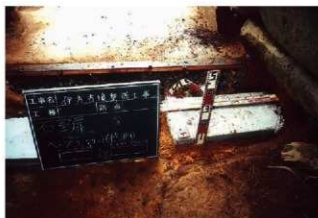
5. 石室入り口部扉ベースコンクリート設置状況
