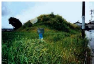
7. 平成 16 年度工事裏側着工前
