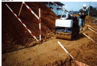
1. 墳丘盛土転圧状況
