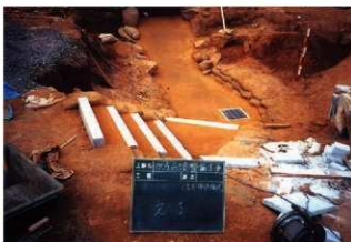
2. 墓道部土系弾性舗装施工状況
