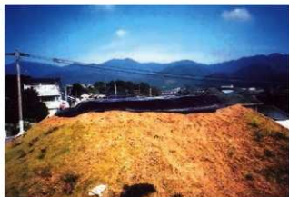
1. 墳丘頂部遮水シート敷設状況
