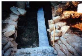
8. 墓道部面上排水材敷設状況
