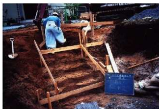
3. 墓道部進入階段床掘状況
