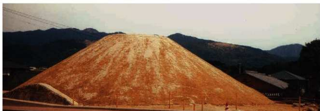
2. 平成 15 年度整備工事竣工
