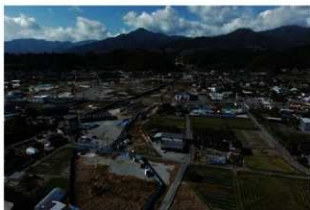
図70 調査区遠景（南東から撮影）
