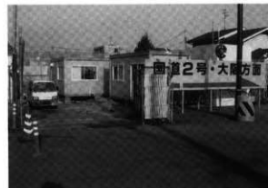
西芦屋町 30 番地に設置したコンテナハウス（西から）
