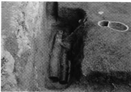
電信柱アンカー（西から）
