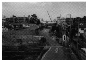
工事中の山手幹線芦屋川トンネル（西から）
