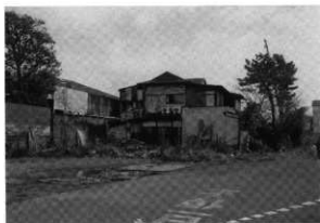
調査地の既存建物（南西から）
