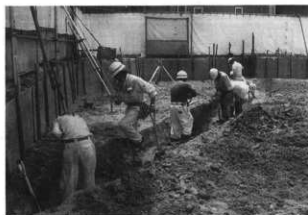
第23図 深基礎掘削時の工事立会状況
