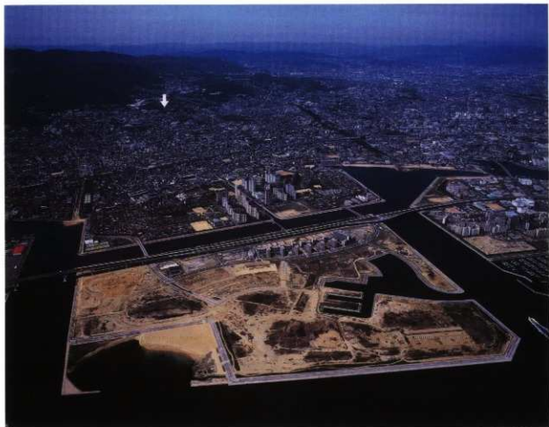
大阪湾上空から芦屋市街地や六甲山東南麓を望む（矢印が調査地、芦屋市広報課撮影・提供〔平成14年〕）
