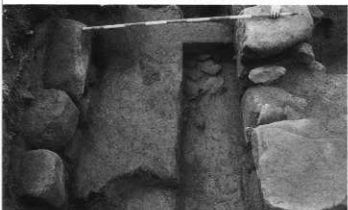
V区 第46号墳 玄室相当部試掘状況〔I〕（奥壁側から）
