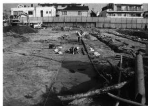
人力掘削状況
