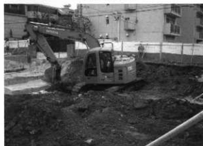
埋め戻し状況
