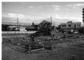
残土搬出状況
