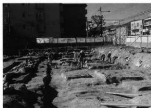
人力掘削状況
