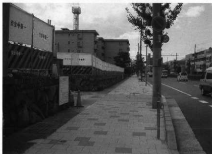
調査地点近景（北東から）
