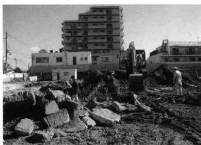
重機掘削状況
