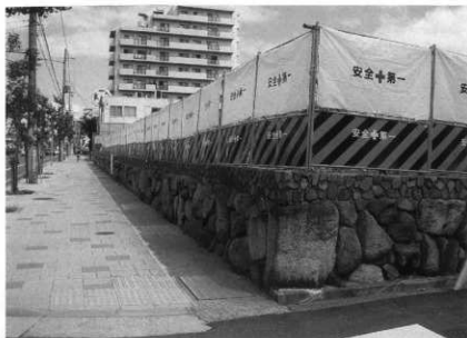
調査地点近景（北西から）
