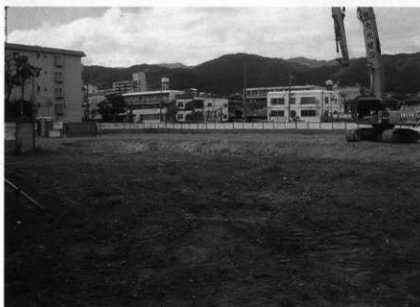
調査地点調査前現況（南東から）
