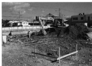
重機掘削状況
