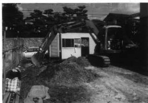
第5図 機械掘削（南から）
