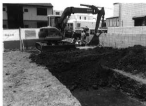
第8図 調査風景（北西から）
