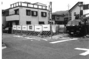
第1図 調査地近景（南東から）
