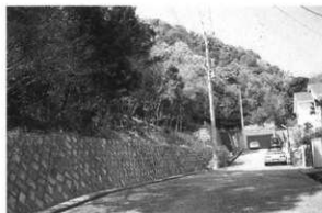
第1図 調査地現況（南東から）
