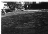
第21図 埋め戻し後 (北西から)
