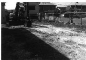
第4図 調査地現況（北から）
