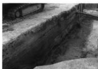
第14図 東トレンチ掘削終了面 検出状況 (南から)
