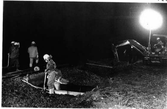
作業風景 (西から)
