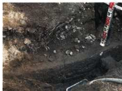
三之丸大手側石垣と三之丸橋の取り付け部
