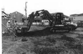
第6図 西区トレンチ1機械掘削(南から)
