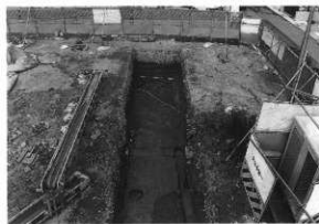
東区 トレンチ1 遺構面3 (西から)
