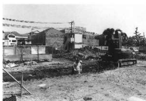
西区 トレンチ2 機械掘削風景（南から）
