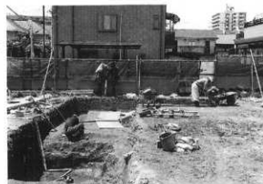
第7図 作業風景(東から)
