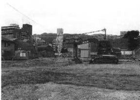
第11図 埋め戻し風景(南から)
