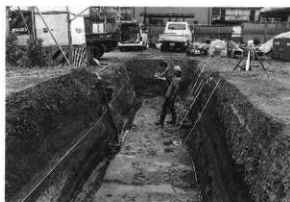
第17図 東区トレンチ1調査風景
