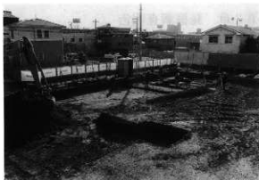
第4図 機械掘削風景（北東から）
