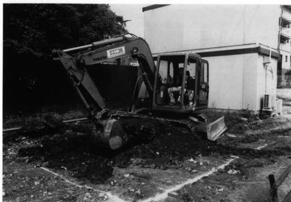
Ⅱ区 機械掘削状況（南から）
