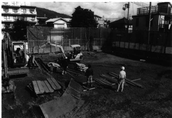
IA区 調査前の状況〔機械掘削前〕（南東から）
