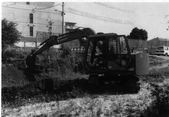
Ⅱ区 機械掘削状況（北から）
