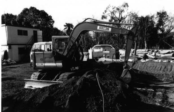
IA区 機械掘削状況（東北から）
