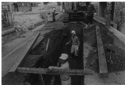
H区 下水道工事風景 (南から)
