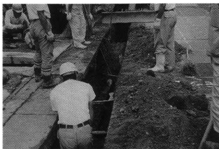
D区 ガス工事風景 (南から)
