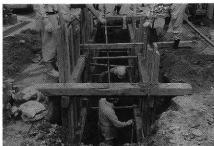
D区 下水道工事風景 (北から)
