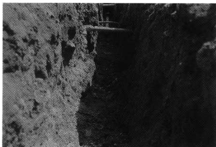
J区 ガス工事 掘削状況 (南から)
