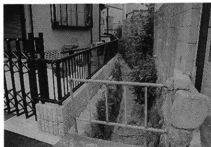
L地点（北から） 住宅街の中に、古い石 垣を残す水路が走行する
