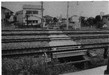
M地点（北から） J R東海道本線を くぐる東川用水
