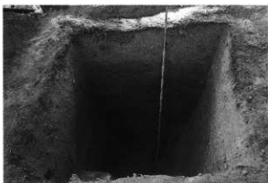
第3トレンチ掘削状況 (南東から)
