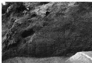
I 区南部西壁土層断面 (東から)
