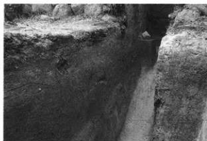
第9トレンチ掘削状況 (南から)
