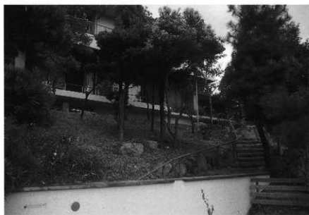
調査地現況（南西から） ※建物の南側は盛土によって庭になっていた。
