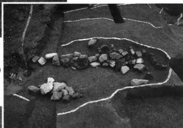
II 区上段池掘削状況（西から）
