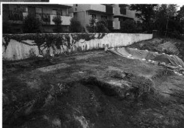
Ⅲ区表土除去状況（南西から）
