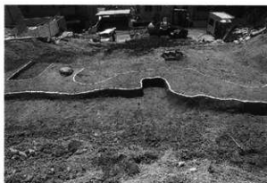
II 区上段第1遺構面掘削状況 (北から)
