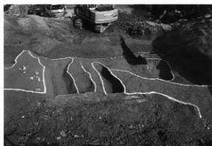
Ⅱ区上段第2遺構面掘削状況（北から）
