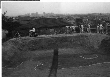
Ⅳ区堀掘削状況（南から）
