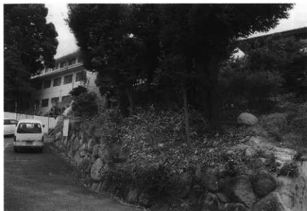
調査地現況（南東から） ※石垣とその前面道路は昭和35年に三糸岡山遺跡発見の端緒となった遺物採集地点である。
